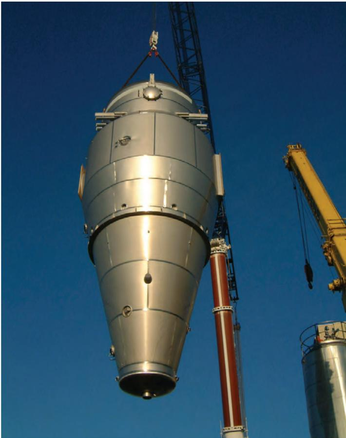
CIP-Filter für einen Sprühturmtrockner mit einem Volumenstrom von 148.000 m<sup>3</sup>/h i. B.
