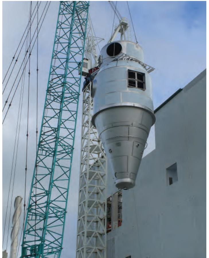
Montage eines CIP-Filter zur Entstaubung eines Sprühturmtrockners mit einem Volumenstrom von 217.000 m<sup>3</sup>/h i.B.
