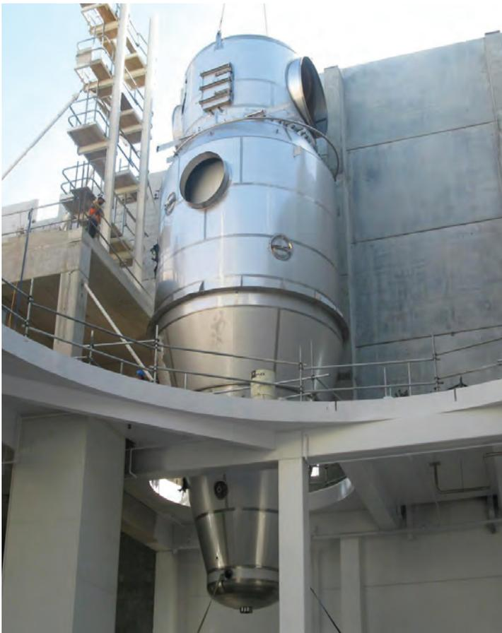
Montage des CIP-Filter für den weltweit größten Sprühturmtrockner
