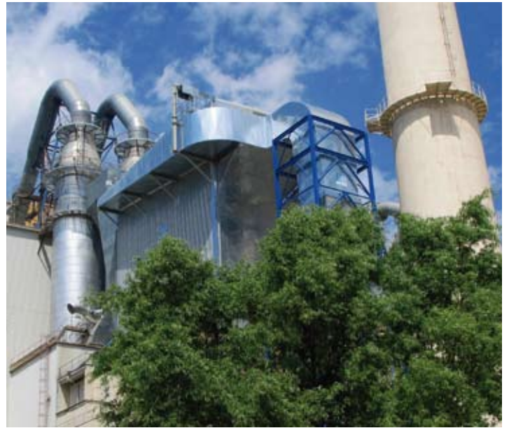
Deuna Zement GmbH, Deutschland (HeidelbergCement) Umbau Elektrofilter CombiJet Doppelfilter in semi-offline Abreinigung Entstaubung Drehrohrofen/Rohmehlmühle
