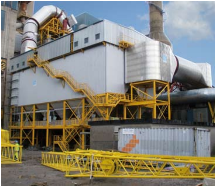
Cementa AB, Werk Slite Schweden (HeidelbergCement) Turnkey Projekt ProJet mega® in offline Abreinigung Entstaubung Drehrohrofen
