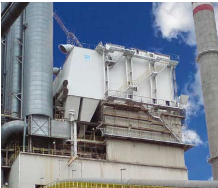
Nowiny, Polen (Dyckerhoff) Umbau Elektrofilter Zwei CombiJet Doppelfilter in offline Abreinigung Entstaubung Drehrohrofen
