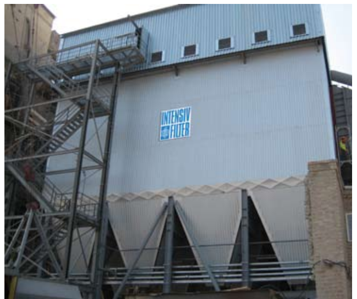
Doncement, Ukraine (HeidelbergCement) Umbau Elektrofilter ProJet mega® in offline Abreinigung Entstaubung Drehrohrofen
