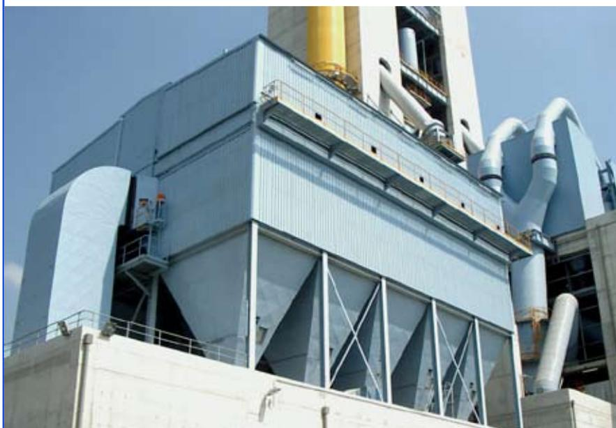
Dépoussiérage des gaz de combustion dans l'industrie des ordures.
